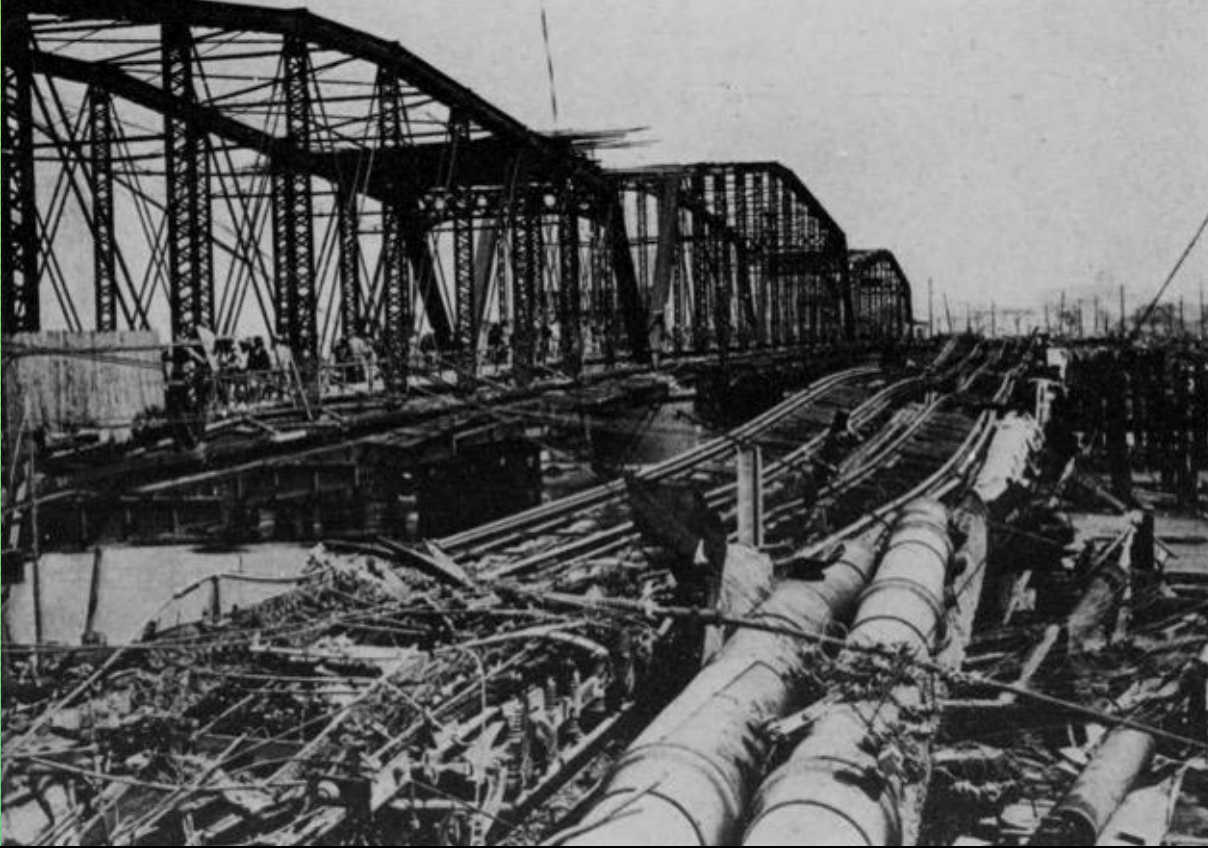
鉄骨を残して焼失した永代橋 (国立国会図書館デジタルコレクションより)
